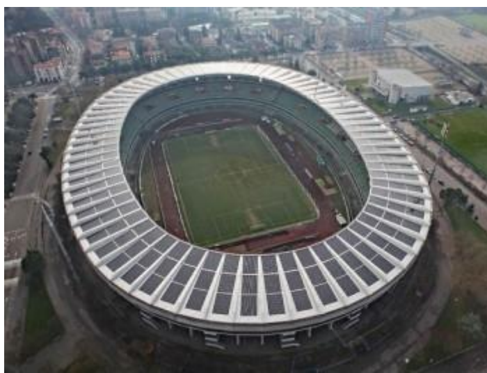
Figura 27 - Il tetto fotovoltaico del Bentegodi di Verona
